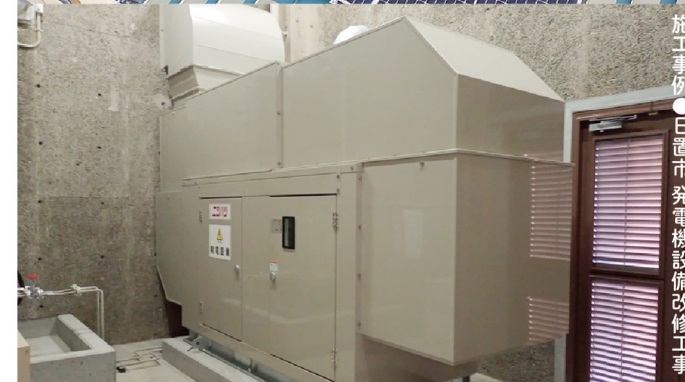
施工事例 ● 特定非営利活動法人 あつたがほーむ愛あい音iOTOさま 太陽光発電システム蓄電池設置工事
